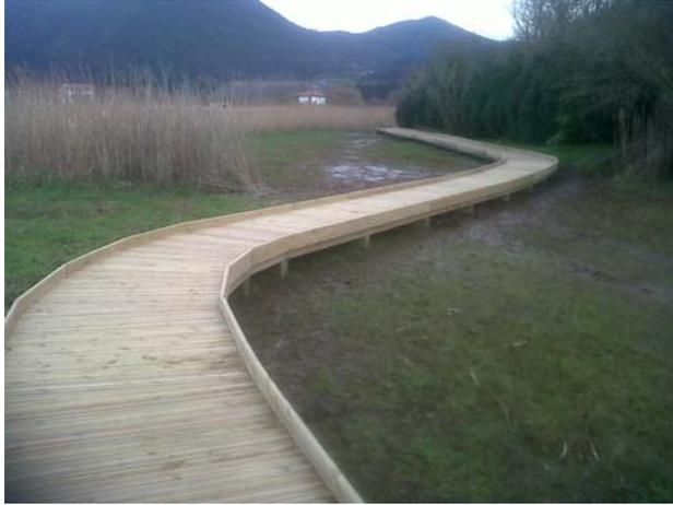
**Figura 8.3.-** Imagen del sendero a base de palafito de madera del tramo de Kortezubi ejecutado
